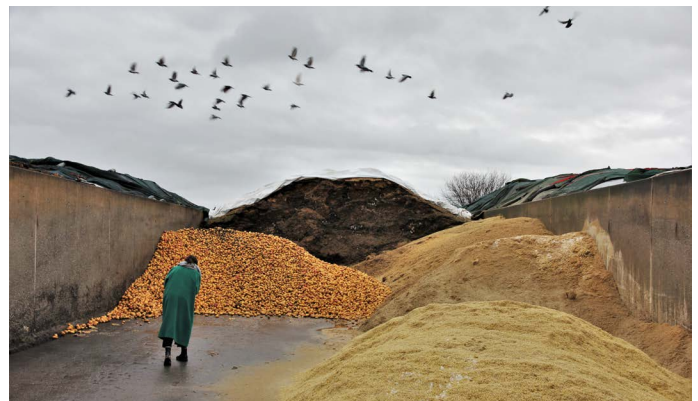
La centrale à biomasse de Beckerich, d'une initiative coopérative à un modèle reproductible ?
