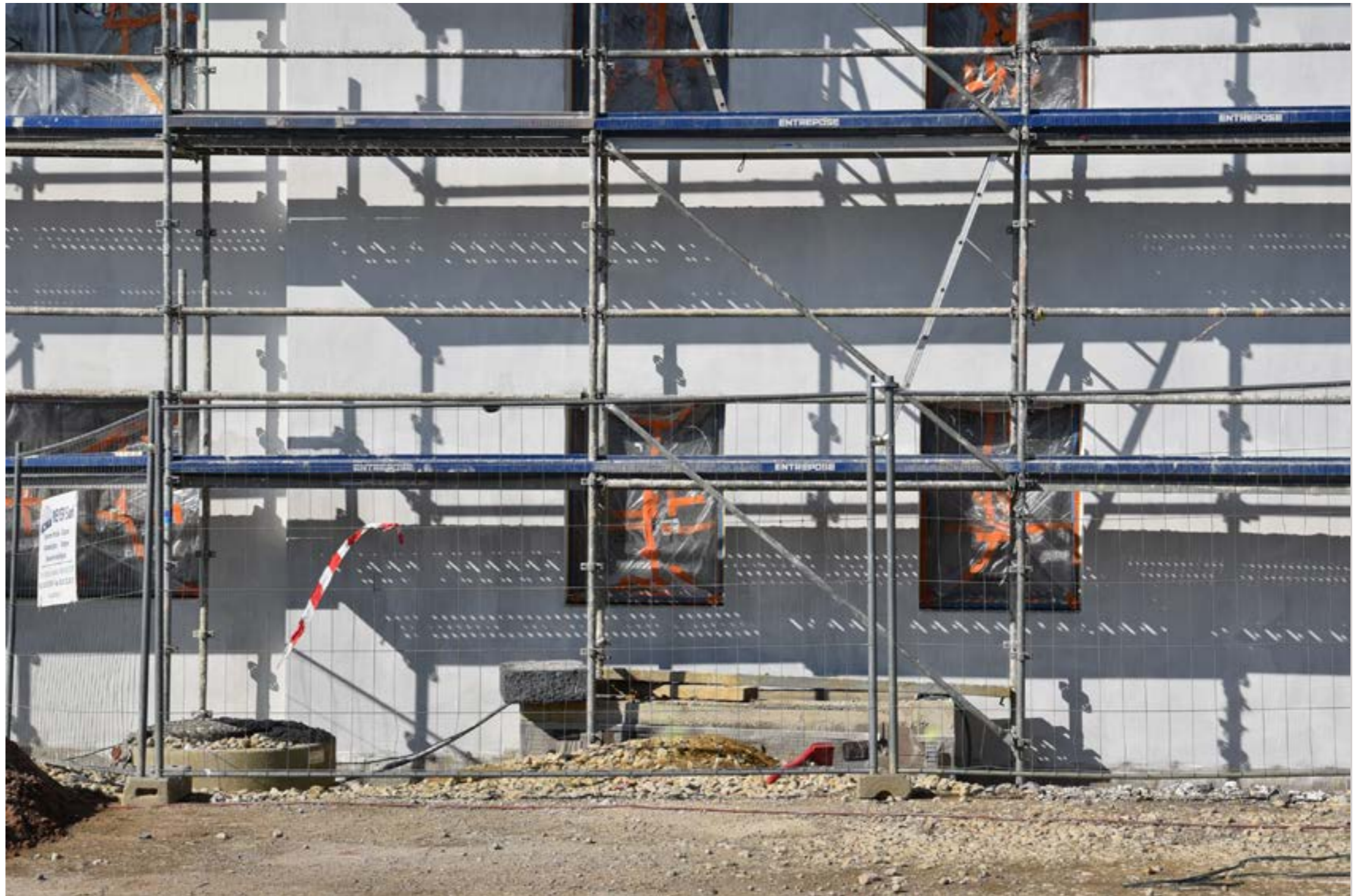
Chantier de logement collectif, Ellange
